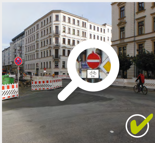
Bild 2 | Arbeitsstellenbedingte Einbahnstraße für Radverkehr freigegeben
