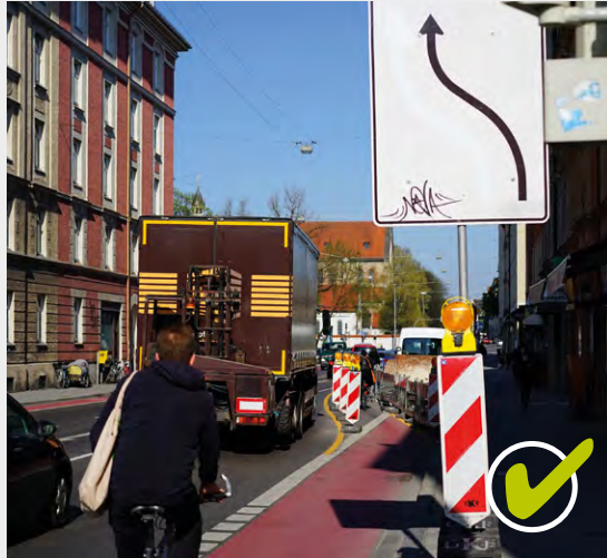
Bild 15 | Arbeitsstelle auf Radfahrstreifen durch Absperrung gesichert
