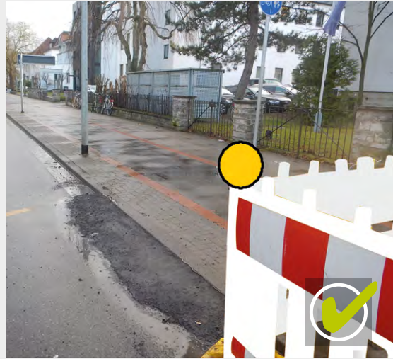
Bild 7 | Anrampung in Form von Asphaltkeil hergestellt
