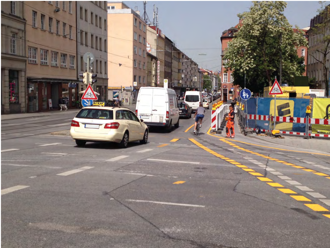
Bild 11a | Deutlich erkennbare Einleitung Radverkehr vom Radweg zur Fahrbahn an einem Knotenpunkt
