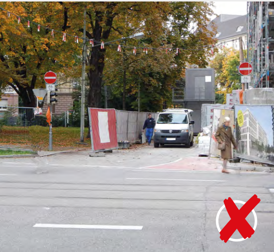
Bild 16 | Nicht geltende Verkehrszeichen sind nicht abgedeckt
