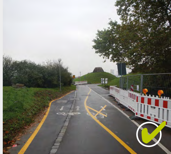
Bild 4 | gut sichtbare Absperrung und Gelb-Markierung
