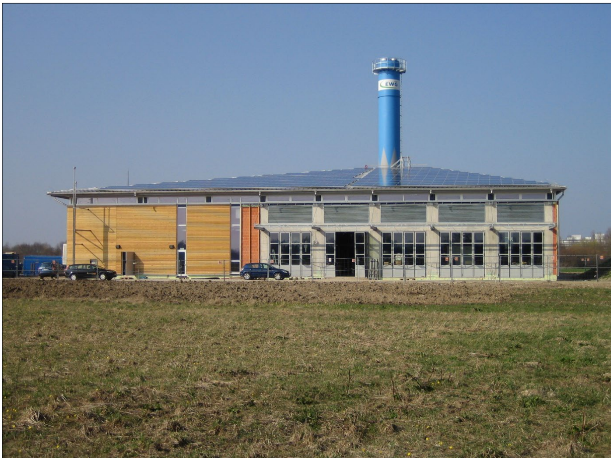
Abbildung 12: Geothermieheizzentrale Garching (Foto Stadt Garching, Mai 2011)
