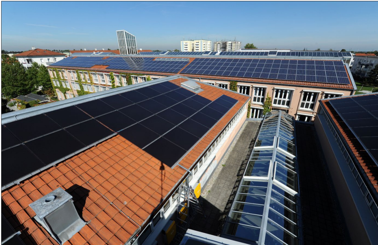
Abbildung 9: PV-Anlage auf dem Rathaus und dem Ratsgebäude (Foto Solarpark Garching, September 2010)
