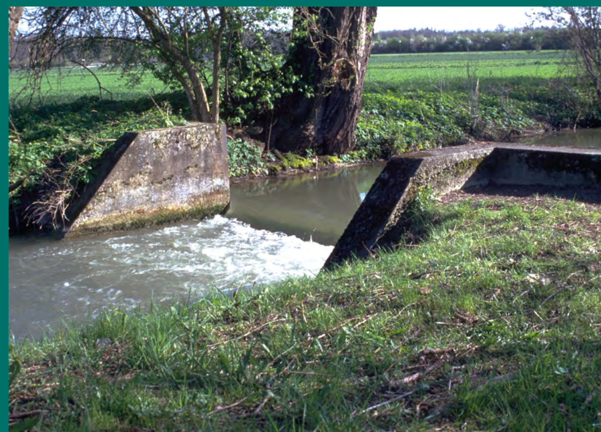
Einstiges Wehr im Mühlbach am Weidenweg
