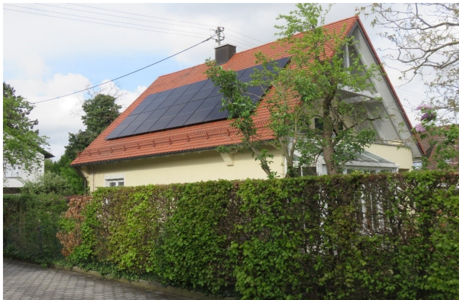
Abb. 1 Photovoltaikanlage von 5 kWp Leistung, westseitig, in der Ausführung „all black“
