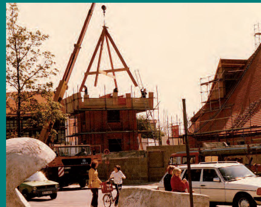
Der Dachstuhl des Turms wird im Sommer 1981 aufgesetzt (Foto: Klaus Werner)
