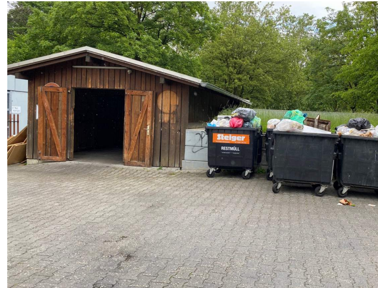
Nebengebäude im Zugangsbereich
