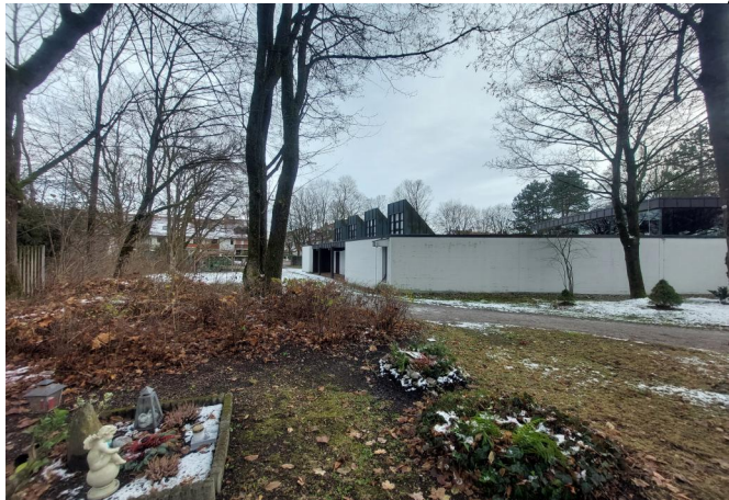
Blick nach Osten auf die Zufahrt zum Wirtschaftshof und Friedhofsgebäude
