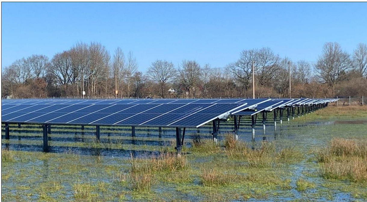
**Abbildung 12: PV-Anlage auf wiedervernässtem Moorboden, Solarpark Lottorf in Schleswig-Holstein** (<https://www.naturschutz-energiewende.de/fachwissen/veroeffentlichungen/photovoltaik-auf-wiedervernaessten-moorboeden-eine-neue-flaechenkulisse-im-eeq-2023/>)
