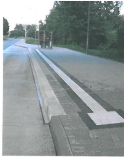
Nach EU-Busrichtlinie müssen Stadtlinienbusse mit fahrzeuggebundenen Einstiegshilfen ausgerüstet sein. Bezogen auf einen 15 cm hohen Bordstein dürfen Rampen eine Steigung von maximal 12 % haben.
