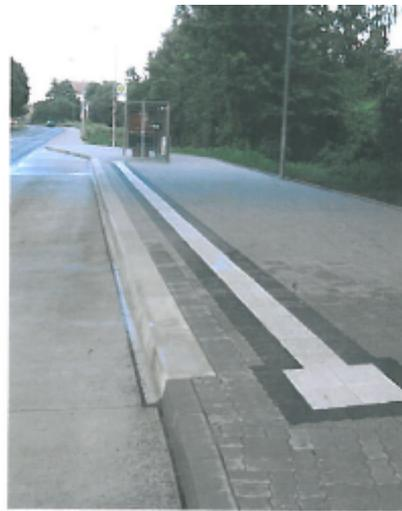
Nach EU-Busrichtlinie müssen Stadtliniensbusse mit fahrzeuggebundenen Einstieghilfen ausgerüstet sein. Bezogen auf einen 15 cm hohen Bordstein dürfen Rampen eine Steigung von maximal 12 % haben.
