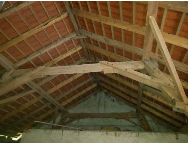
Dach Stall mit Heulager Gebäude A
