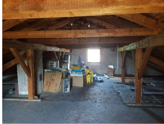
Kaltdach Gebäude B
