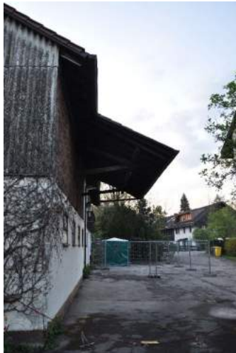
Seitenansicht Gebäude A
